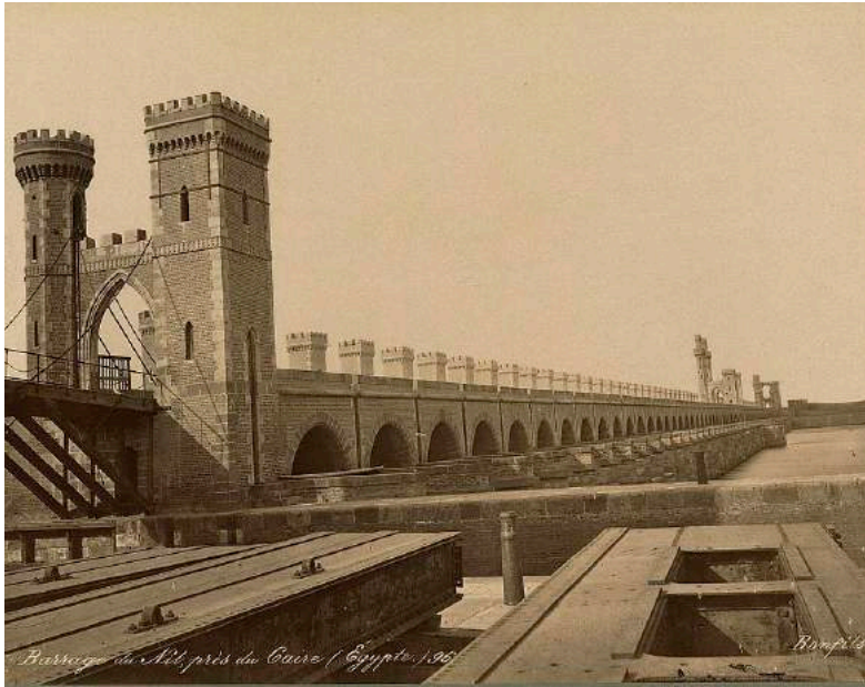
Figure 2 Felix Bonfils, Barrage du Nil, près du Caire (Égypte) (Damietta branch of the Barrages). Source: Library of Congress Prints and Photographs Division, Washington D.C.
