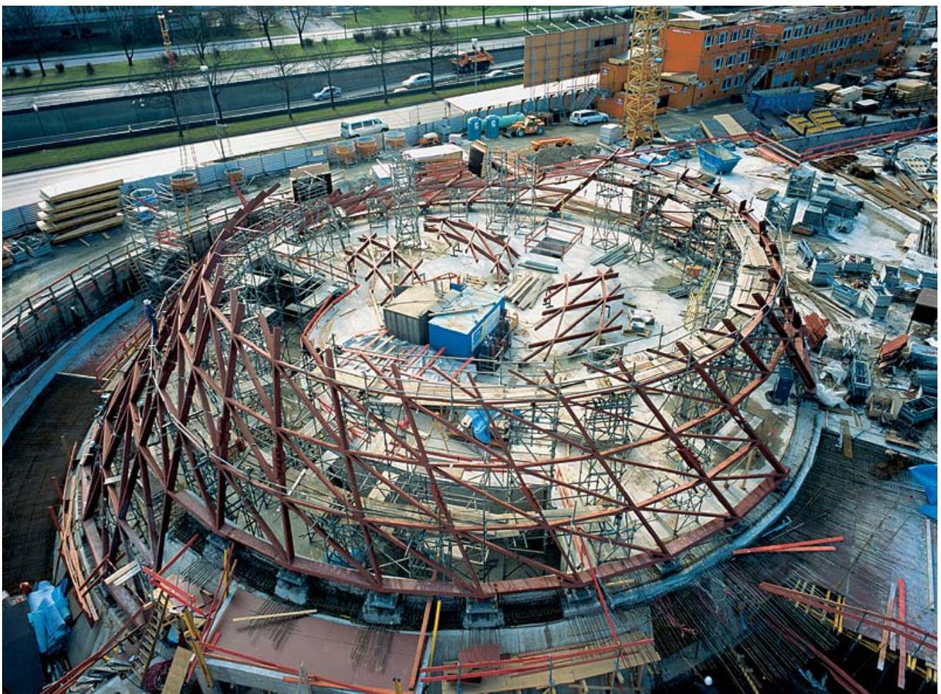
Abbildung 6: Tragwerk des Doppelkegels in der Bauphase [7]
