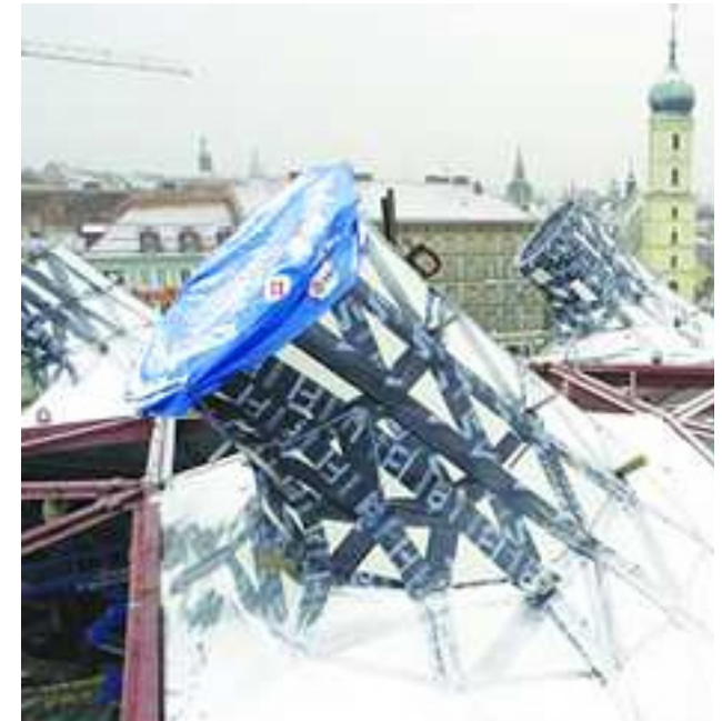
"Nozzle" im Bau
