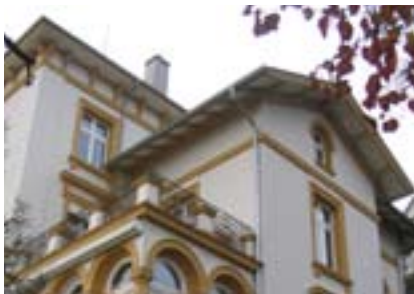
Dach Walmdach und Satteldach
