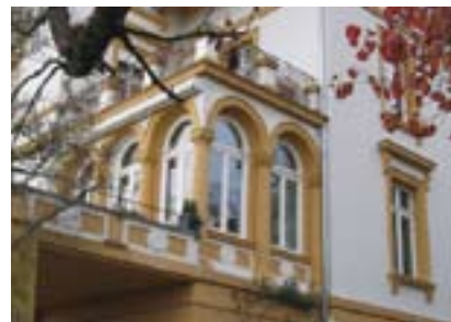
Fassade Balkon auf der Südseite
