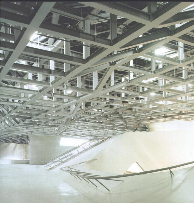
**Fotografie 8:** Der Übergang vom Boden zur Wand ist fließend und endet in der Stahl-Kassettendecke.
