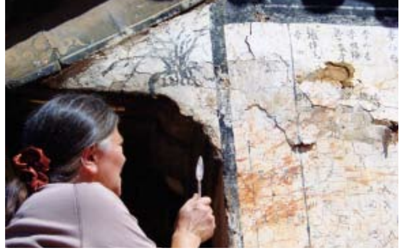
Sorgfältige Restaurierung einer Fassadenmalerei in Shaxi.
