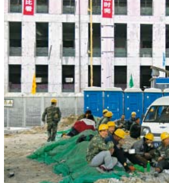
Mittagspause auf der Baustelle.
