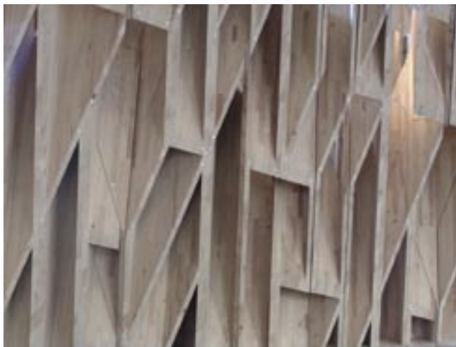
«Futuropolis» besteht aus 360 m 2 stabverleimten Birkenplatten. Die einzelnen Elemente sind mit Aluminium-Schwalbenschwänzen miteinander verbunden.
