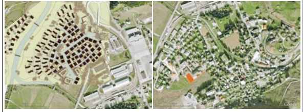
links: Andermatt, Projektgebiet Siedlung, GoogleEarth 2009 rechts: Andermatt, GoogleEarth 2009
