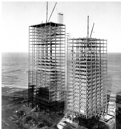
Abbildungen: Mies van der Rohe, Lake Shore Drive Apartments, Aufnahme der Bauarbeiten 1948-51
