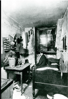
92 Kellerwohnung, Berlin, 1908. Der Keller war von elf Mietparteien belegt.
