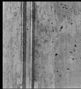
Louis I. Kahn, Betonwände und Fugendetail, The Salk Institute, La Jolla, 1959-65
