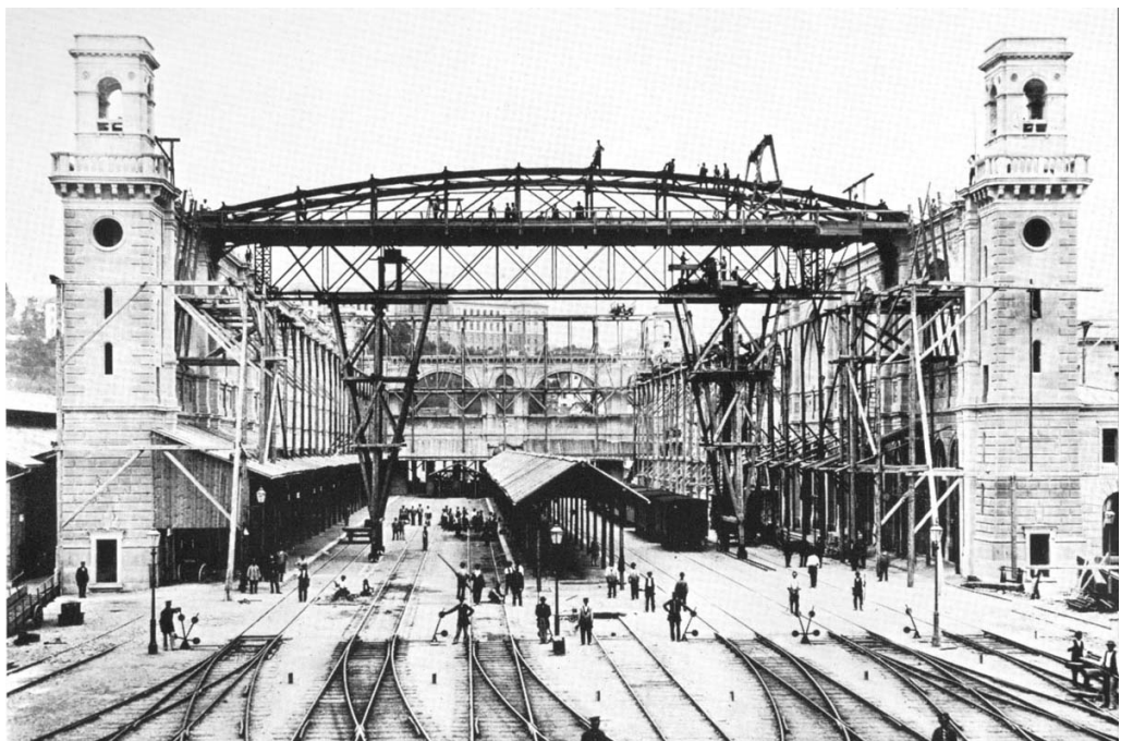
Die Bahnhofshalle des HB Zürich während dem Bau 1870.
