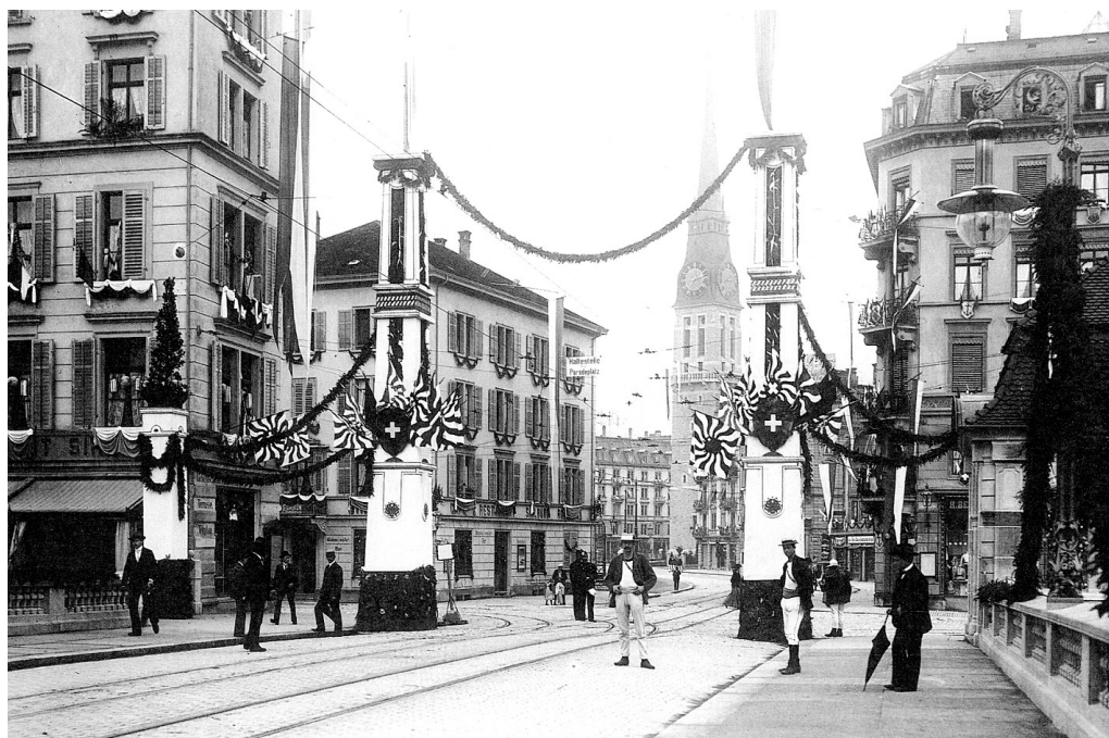
Das Tor zu Aussersihl gut hundert Jahre später. Aus Anlass des eidgenössischen Turnfestes von 1903 mit zwei Türmen, Girlanden und Fahnen betont und geschmückt. Die beiden Häuser, welche die Sihlbrücke flankieren, stammen aus den 1870er-Jahren.
