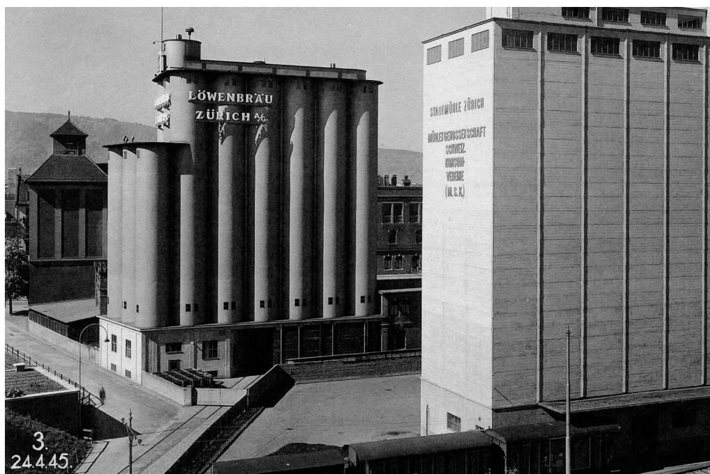
Silotypologie auf dem Areal der Löwenbräu und der Swiss Mill am Sihlquai. Backstein-Silotürmchen von 1925, Stahlsilo für Malz und Kohle von 1938, Betonsilo für Getreide von 1936.
