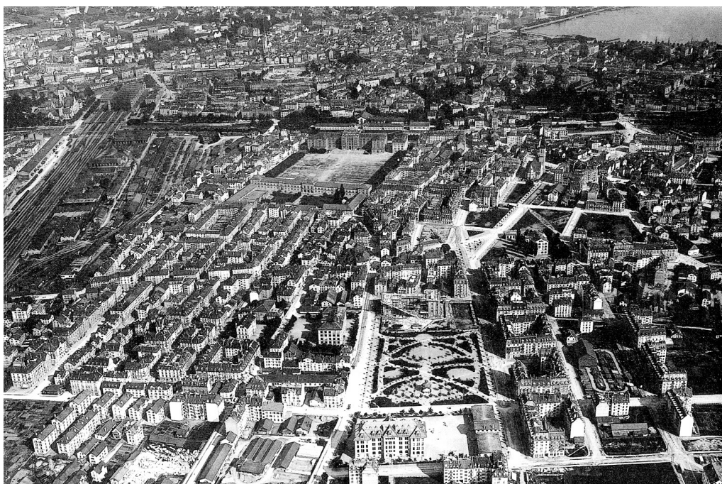
Aussersihl aus dem Luftballon, 1903. Aus der kompakten Blockrandbebauung stechen die Freiflächen der Kasernenwiese und der Bäckeranlage hervor.
