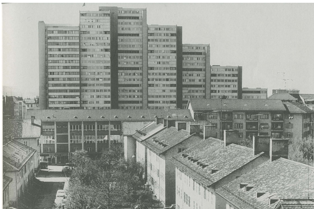
Philanthropischer Wohnungsbau. Die Aktienhäuser der Aktiengesellschaft für die Erstellung von Arbeiterwohnungen an der Kalkbreite. Zwei lang gestreckte Zeilen mit grossen (Nutz-)Gärten. Erbaut von 1862 bis 1864, abgerissen 1979, um einer intensiveren Ausnützung Platz zu machen. Dahinter das Lochergut, 1966 von Karl Flatz, Badenerstrasse 244, gemeinnütziger Wohnungsbau ein Jahrhundert später.
