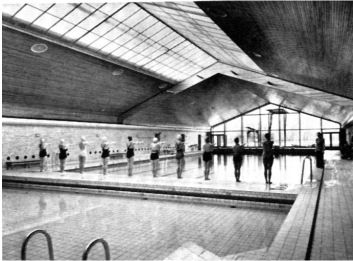
Schwimmhalle im Staatlichen Gymnastikinstitut, Kopenhagen, 1940, Architekt: E. Thomsen.
