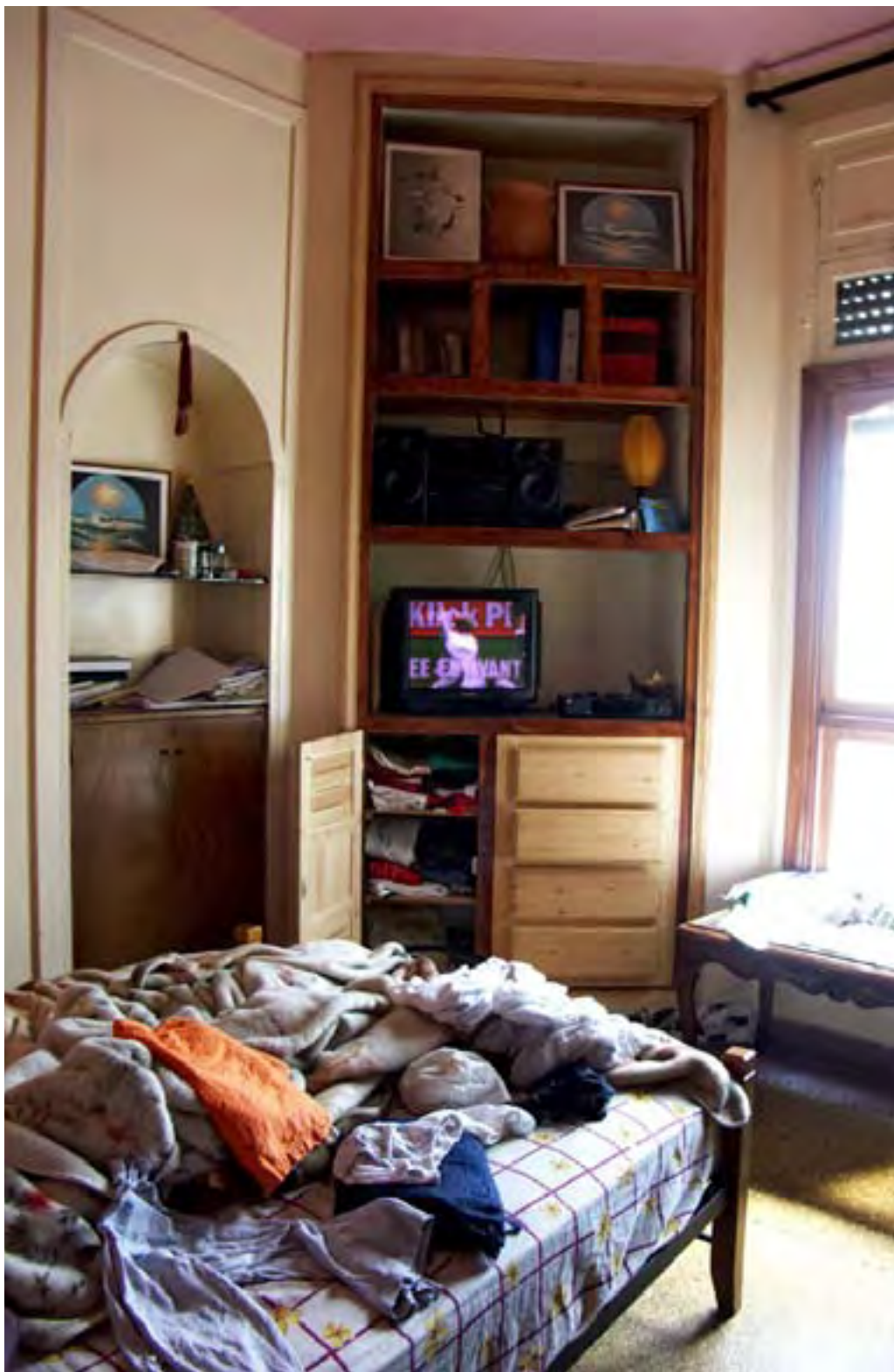
In den Hohlräumen der Aussenwände wurden Tablare und Schränke eingebaut
