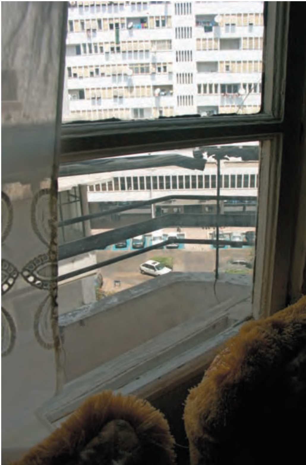
App. ésc. C, ét. 4, ouest, Immeuble Asayag. Um die Salles Marocaines einrichten zu können werden, die Balkontüren und die französischen Fenster zugemauert.
