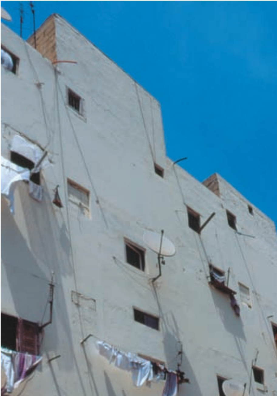
Fassade der Scheibe, Carrières Centrales Zustand 2005
