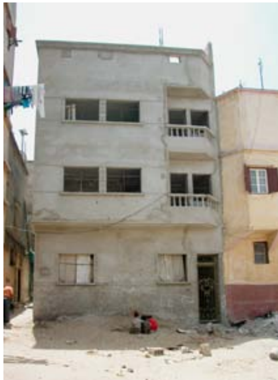
Neubau in Carrières Centrales
