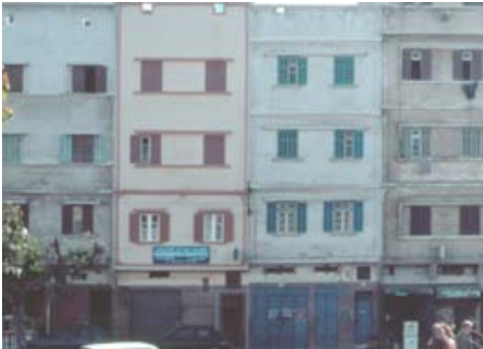
Einheitliche Fassadengestaltung: Lochfenster und Gesimse
