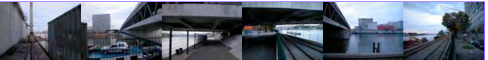
Drei-Rosen-Brücke, St. Johann Terminal
