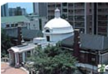
57 Hung Hing Ying Building deklariert 1995
