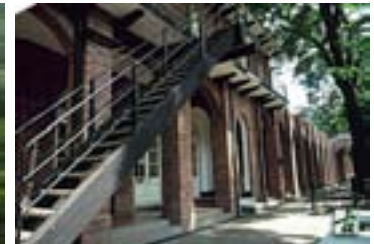
12 Old District Office North deklariert 1981 1907
