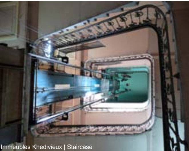
Immeubles Khedivieux | Staircase
