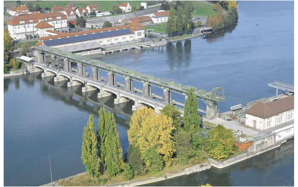
Airal View Kraftwerk Augst /BL
