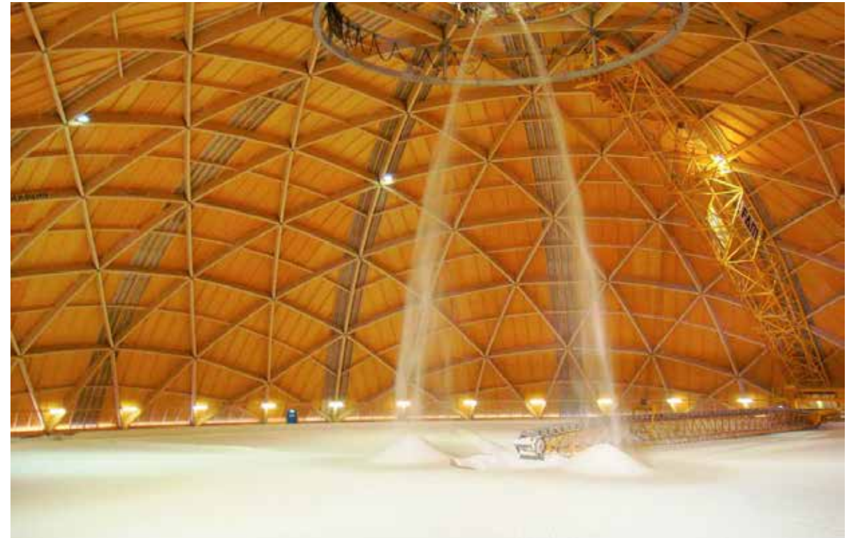
The Salt Storage Saldome in Riburg/AG ( www.badischerzeitung.de )
