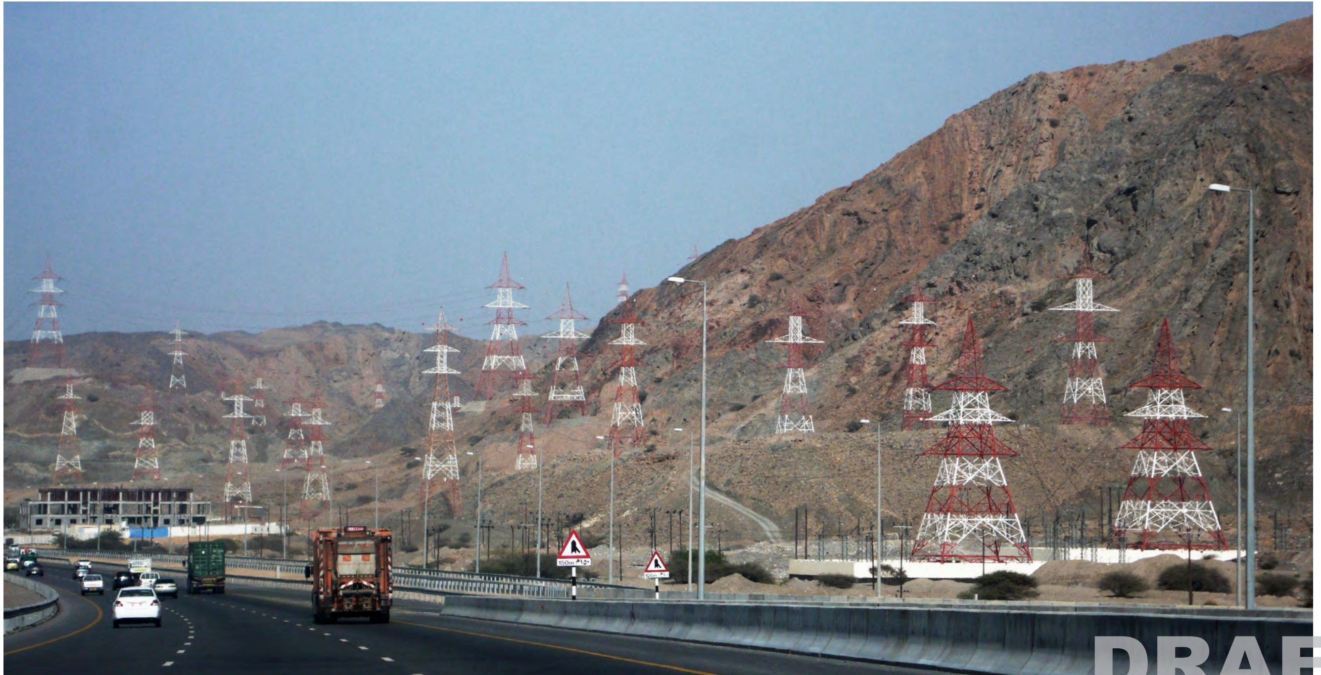
Stromfreileitungsmasten entlang des Express-Highway
