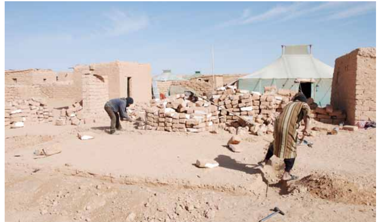
El Aaiún, construction site
